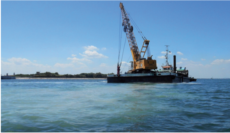
Draga a grappo, operazioni di scavo materiale dal recesso di barriera presso la bocca di porto di Chioggia. Il sedimento risospeso dalla draga viene trasportato in sospensione dalle correnti generando il pennacchio di torbida.
