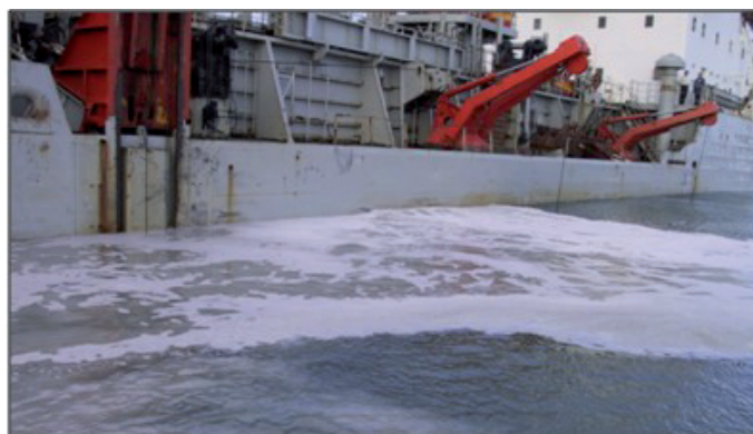
La draga idrorefluente a sfioro Astra in opera presso la bocca di porto di Lido.
